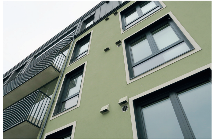
Den grønne fasaden er lett gjenkjennelig.
