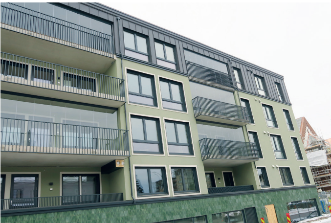
Fasadeuttrykket er enkelt og tidløst.
